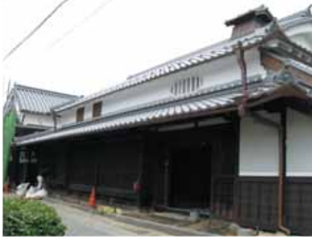
改修が進む 藤岡家住宅 (玄関)
