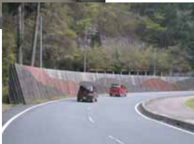
7. 落石防止擁壁化粧仕上げ
