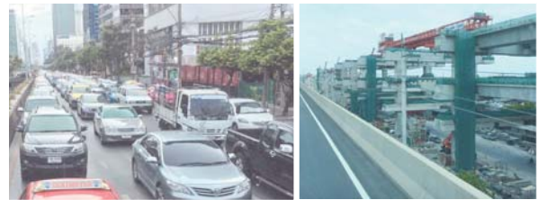
バンコク名物の交通渋滞（左）と建設中の地下鉄（右）
