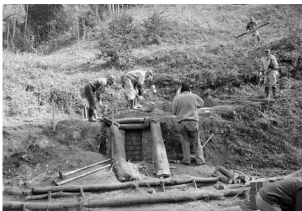
窯の上の天井の土を踏み固める作業
