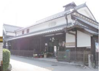
藤岡家住宅（五條市近内）の外観（上）
