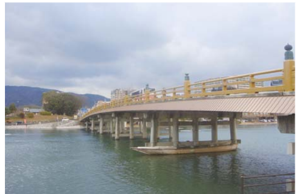
瀬田の唐橋現況（滋賀県大津市瀬田）
