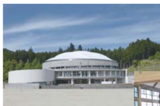
ドーム型屋根が特徴の御杖小学校（左）
