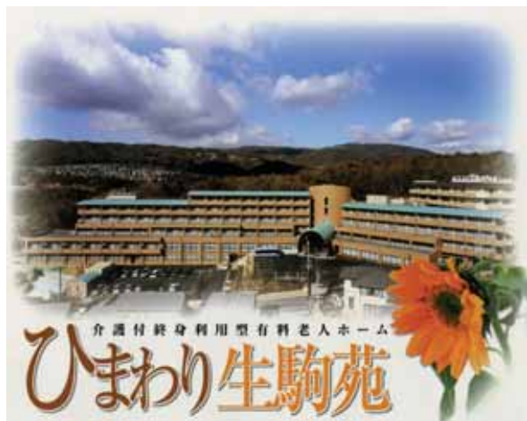
「ひまわり生駒苑」全景（同苑パンフレットより）
