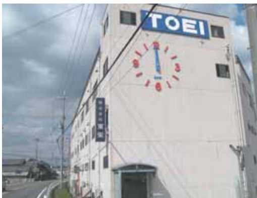
本社社屋全景
