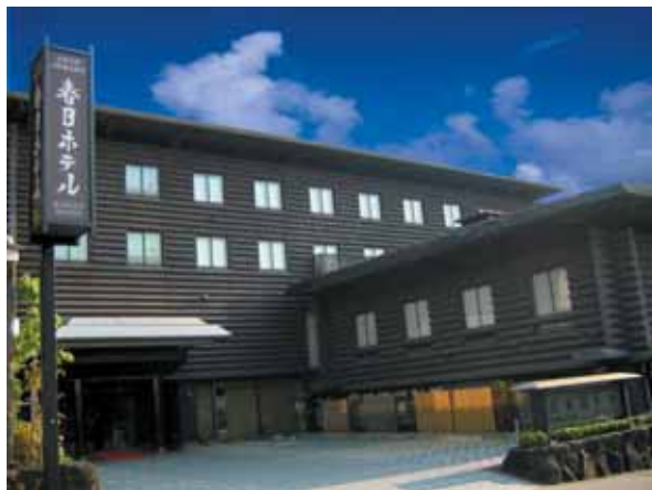
春日ホテル 正倉院の校倉造りを模した外観
