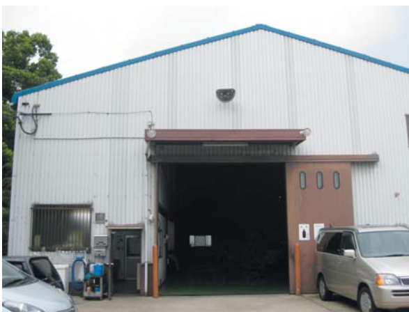
有限会社小倉重量事務所の外観（大阪府藤井寺市）
