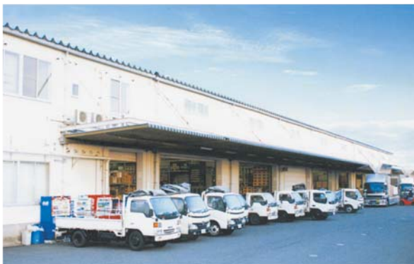
物流拠点を併設する本社建物
